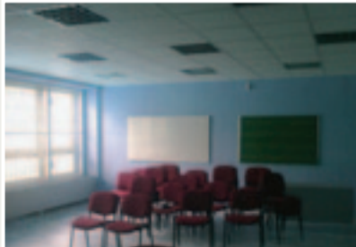
Trieda po rekonštrukcii
