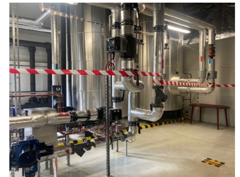
Zrenovovaná kotolňa na ulici Pod záhradami v Dúbravke
